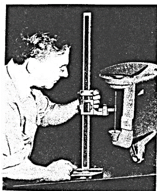
شکل (۹-۴) کولیس ارتفاع‌سنج
