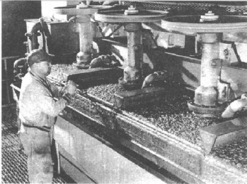
۲۱ Mechanical flotation cells
